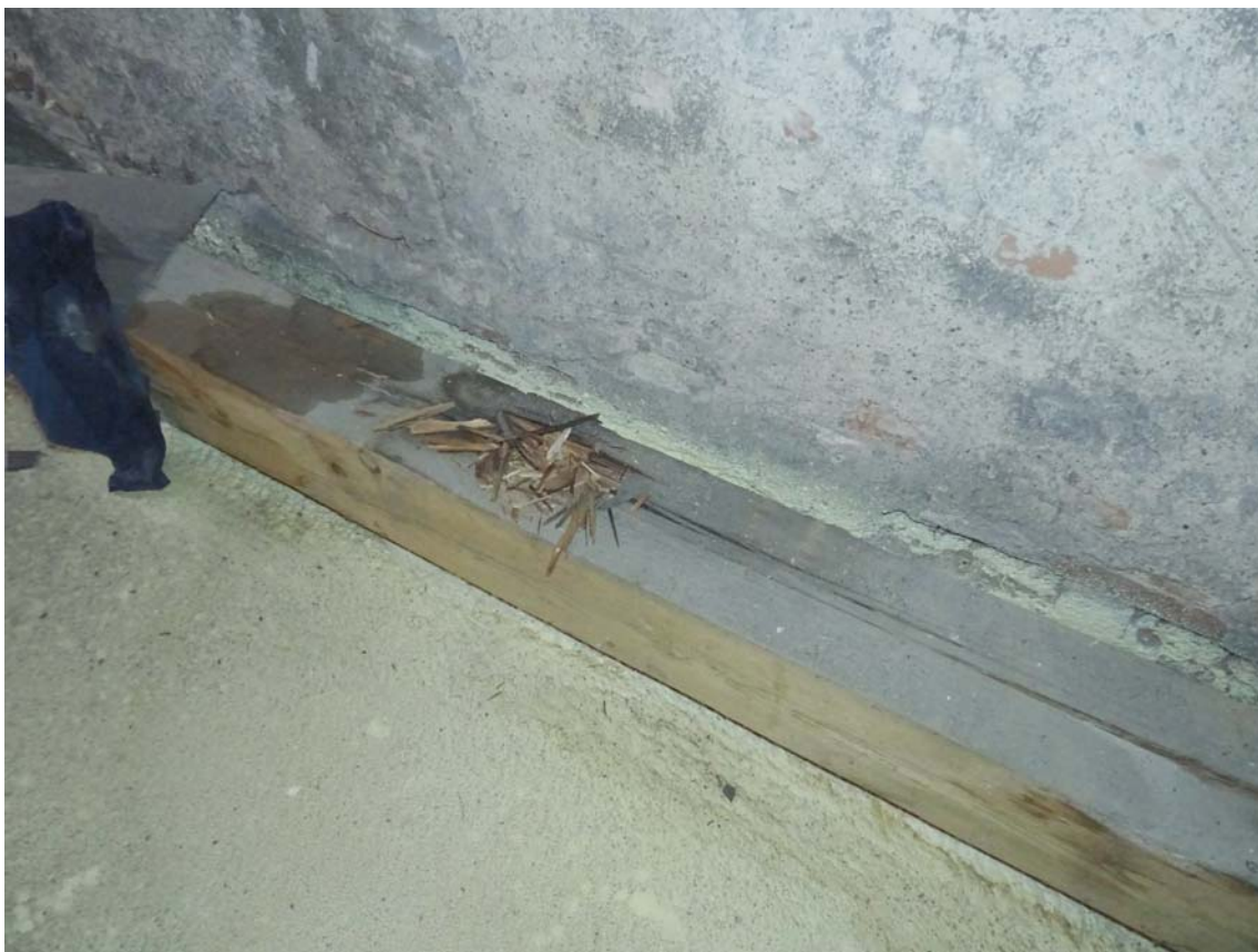
14. Zatékáním narušený vazný trám plné vazby 1P (západní štít)
