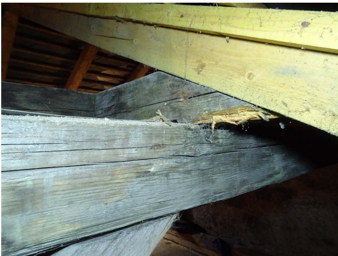
16. Dřevokazným hmyzem narušený hambálek (krátký) ve vazbě 4
