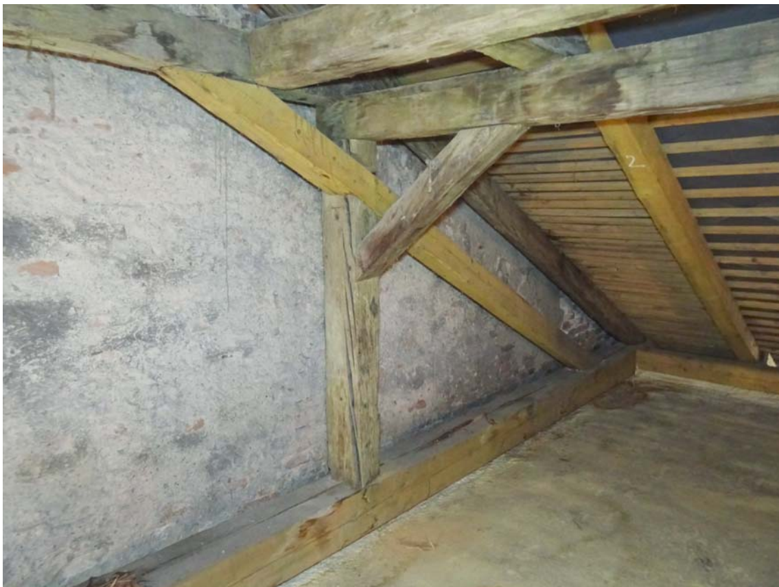
13. Zatékáním narušená plná vazba 1P (západní štít)
