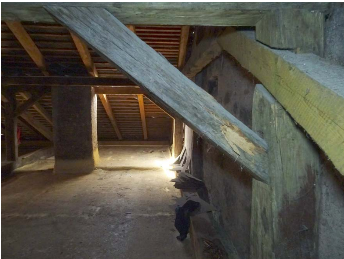
15. Dřevokazným hmyzem narušený pásek ve vazbě 1P
